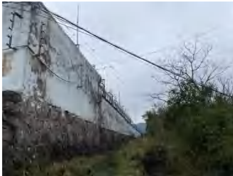
图 2-2 牌头 220kV 变电站间隔扩建侧现场照片
