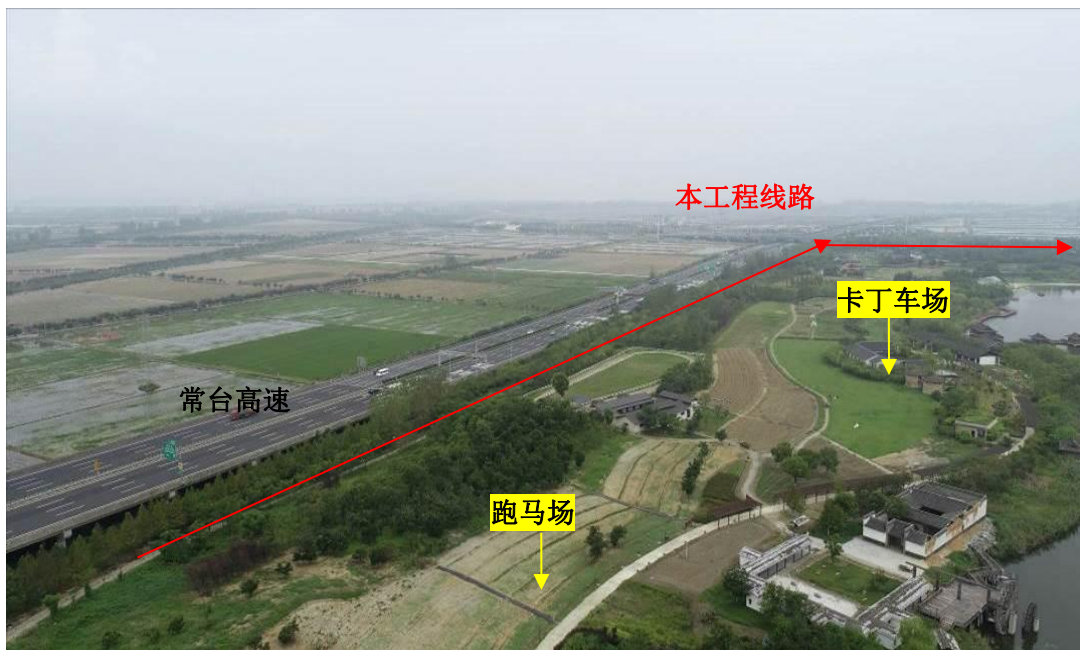
本工程线路穿越上虞杭州湾海上花园湿地公园照片
