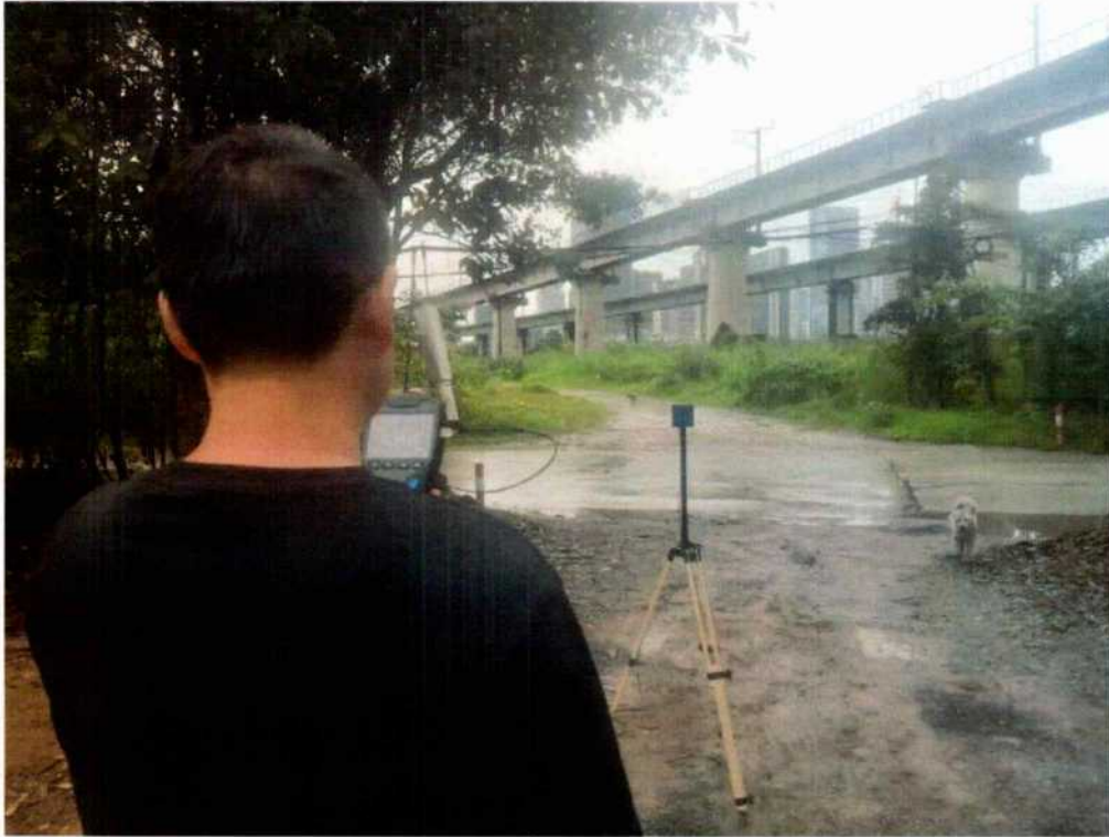
电缆线路断面检测
